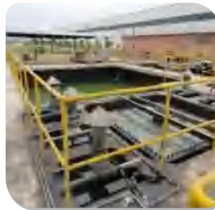
公司有污水处理站6个，日处理水量在 2975 立方米左右，主要对表面处理废水、熔炼用冷却水和清洗废水进行处理，经处理合格后中水由公司内部回用，部分纳管排放，并按照公司的相关文件执行。生活污水、食堂含油废水经隔油池、化粪池后排入市政污水管网。甘肃海亮含铜废水采用“二级RO+EDI+EMD”；含铬采用“化学沉淀”；综合废水采用“吸附+化学沉淀”后达标排放。
