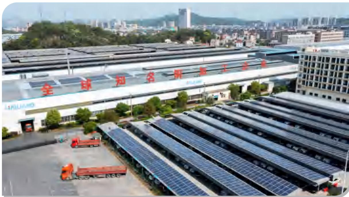
公司已在厂房屋顶安装大量多晶硅光伏组件，用于光伏发电，国内基地总装机容量约63.3MWp，2022年发电量6862.16万kwh，可减少39869.15t二氧化碳排放。
